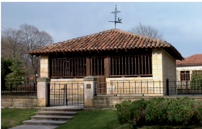
Casa de Juntas de Puente San Miguel reconstruida
