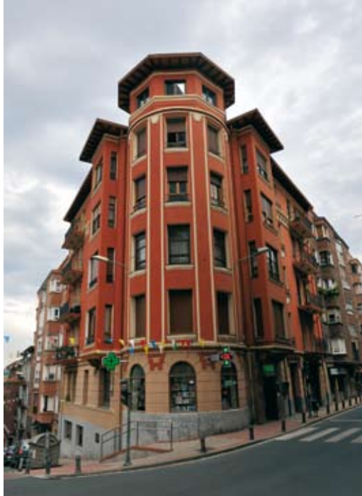
Edificio de Viviendas Santos Zunzunegui, 1931 Txabarri, 22
