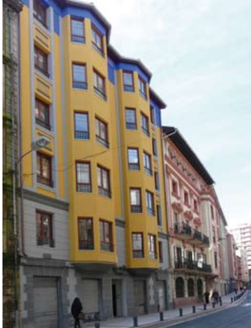
Edificio de Viviendas Santos Zunzunegui, 1925 Txabarri, 71
