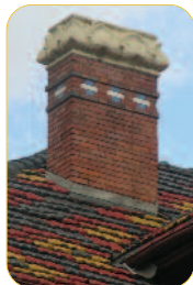
DETALLE DE LA CHIMENEA.
