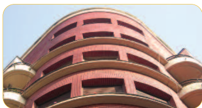
DETALLE DE FACHADA.
