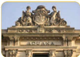
DETALLE DE FACHADA.
