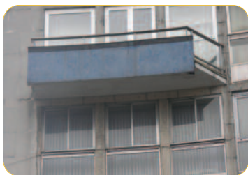
DETALLE DE FACHADA.
