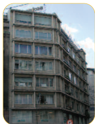
DETALLE DE FACHADA.
