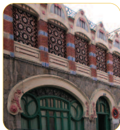
DETALLE DE FACHADA.
