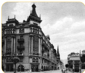
VISTA DE CONJUNTO, 1957.
