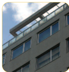
DETALLE DE FACHADA.
