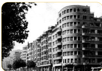
VISTA DE CONJUNTO, 1957.
