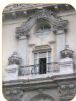
DETALLE DE FACHADA.
