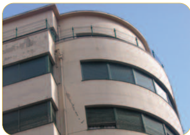
DETALLE DE FACHADA.
