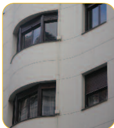
DETALLE DE FACHADA.
