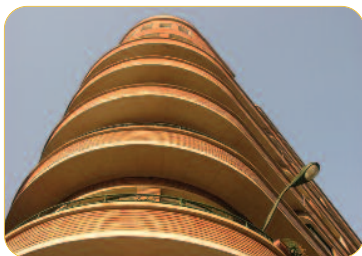
DETALLE DE FACHADA.
