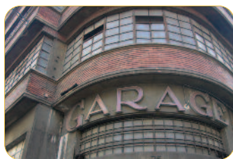
DETALLE DE FACHADA.
