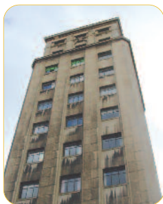
DETALLE DE FACHADA.
