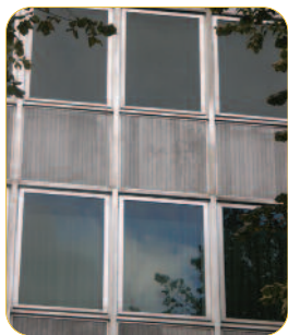
DETALLE DE FACHADA.
