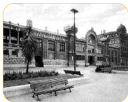
VISTA DE CONJUNTO, 1957.
